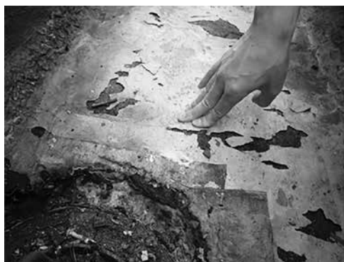
写真5 既存アスファルト防水層撤去後の 躯体状況確認
