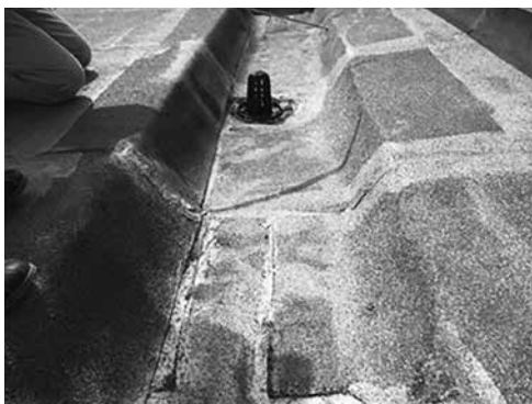
写真1 既存アスファルト防水層に浮き・剥がれがある状態
