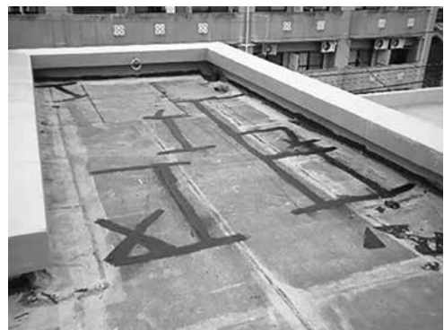
写真2 既存アスファルト防水層の脆弱部
