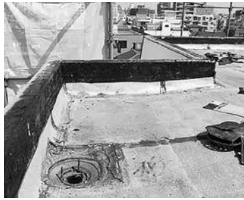
写真8 既存アスファルト防水層を立上がりりでカット
