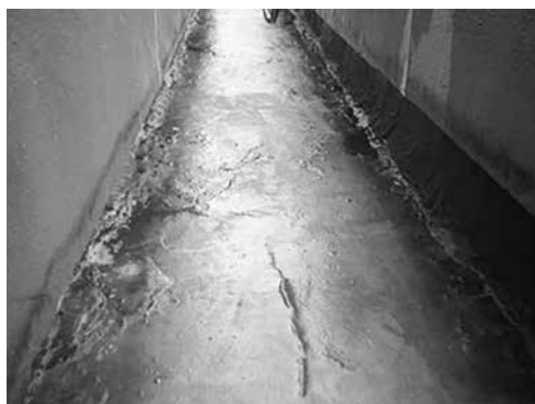
写真6 躯体からのエフロの滲出や表層の凹凸に注意
