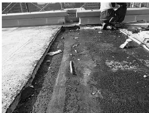
写真3 スラブに打継ぎがあった事例
