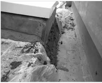
写真7 複雑な形状の補修には時間もかかるので注意が必要である
