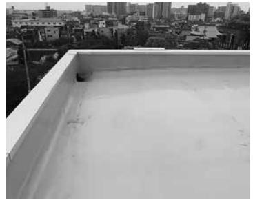
写真9 ウレタンゴム系塗膜防水(かぶせ工法)の点検確認
